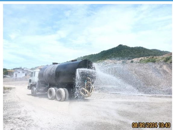
รูปที่ 3-6 การฉีดพรมน้ำ เพื่อลดการฟุ้งกระจายของฝุ่นละอองภายในพื้นที่โครงการ
